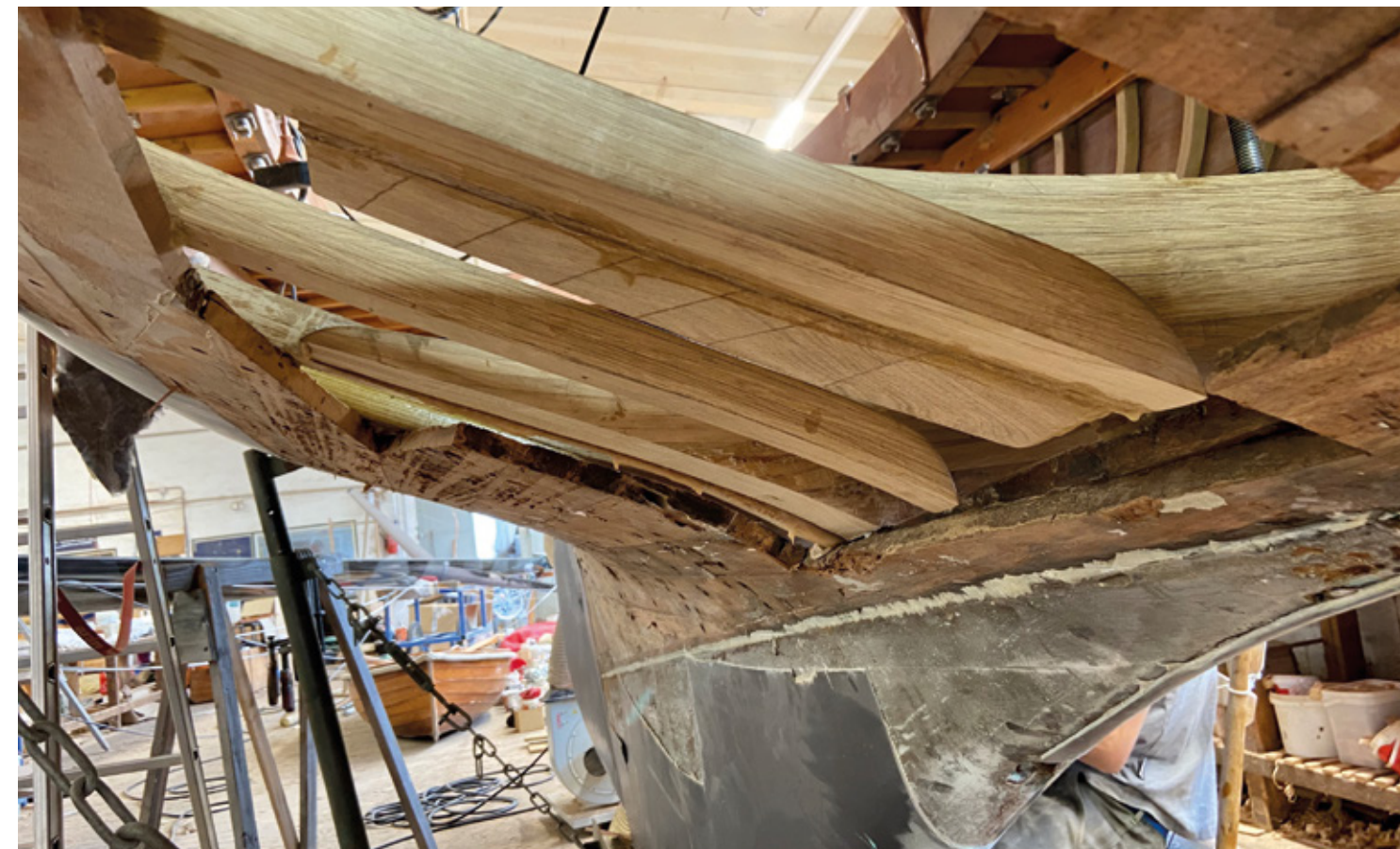
Insgesamt wurden zwischen Ruderkoker und Vorschiff 22 Spanten und elf Wrangen ersetzt.
