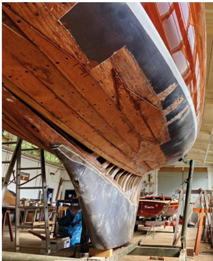
Von innen nach außen. Nachdem im Rumpf Spanten und Wrangen erneuert wurden, wird der Rumpf wieder geschlossen.
